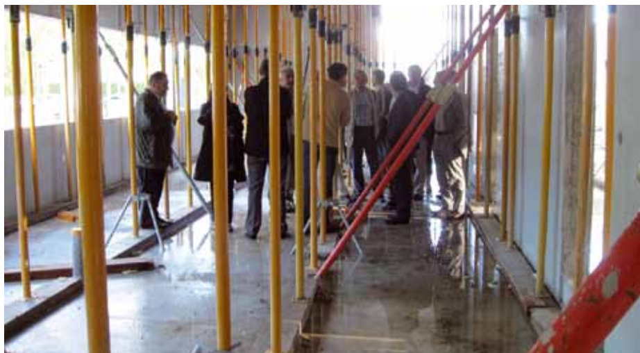
▲ Visite du chantier, le 26.09.2012
